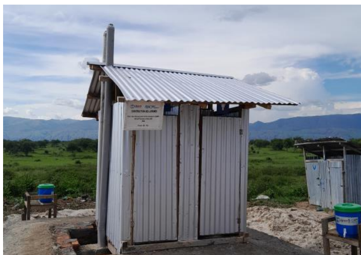
Latrines construites dans le site Tchomia, Ituri © OIM RDC 2023
